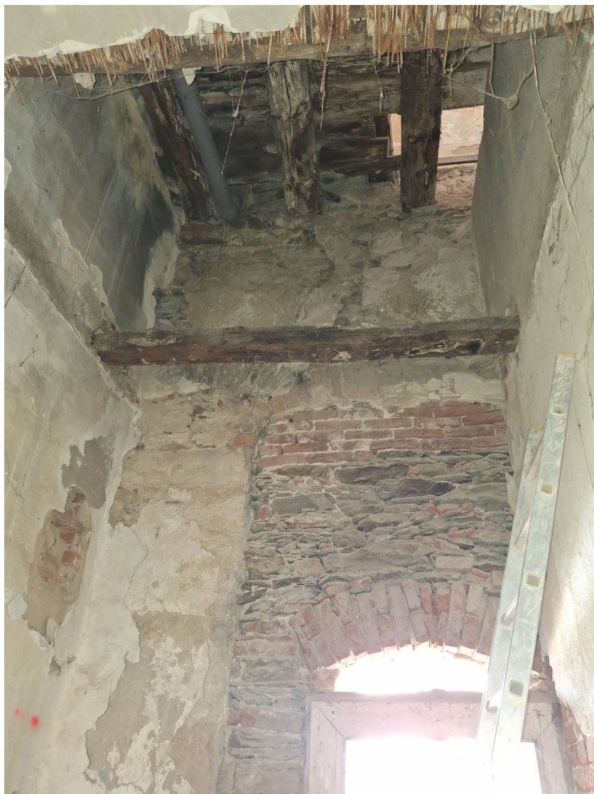
3. Dřevokaznou houbou napadená část stropní konstrukce 1.NP (jižní užší místnost)
