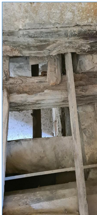
Obr.č. 1 - 2 – SONDA 2.04 – NOSNÉ STROPNÍ TRÁMY - INDEX x(D)
