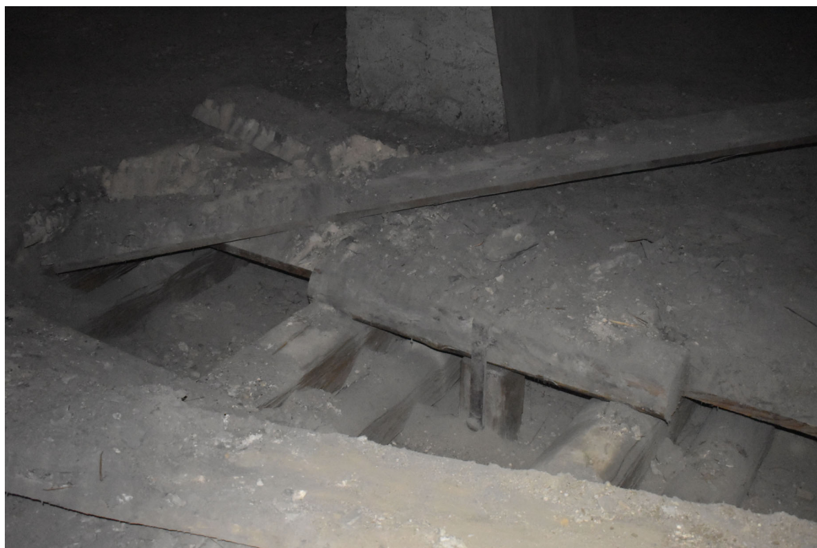
8. Horní zhlaví vyvěšujícího dřevěného sloupku (stropní konstrukce 2.NP)
