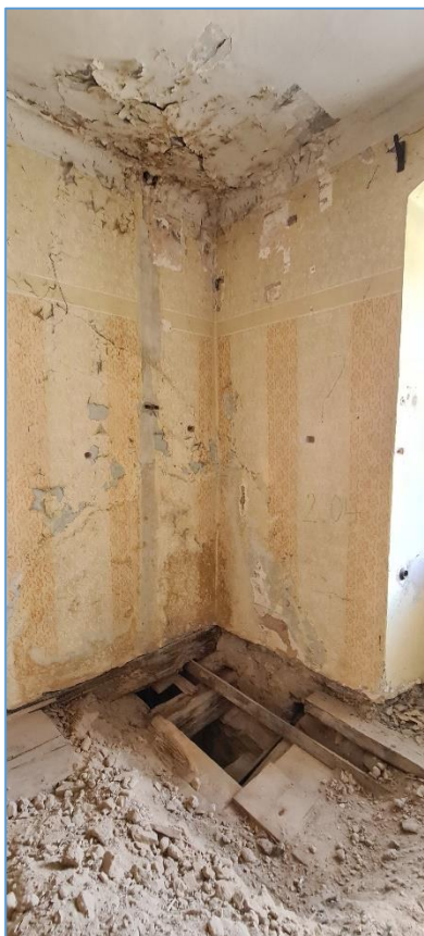
Obr.č. 1 - 2 – SONDA 2.04 – NOSNÉ STROPNÍ TRÁMY - INDEX x(D)
