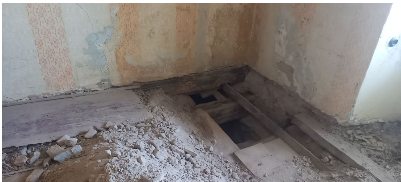
1. Dřevokaznou houbou napadená část stropní konstrukce 1.NP v místě cihelné příčky (severní větší místnost)
