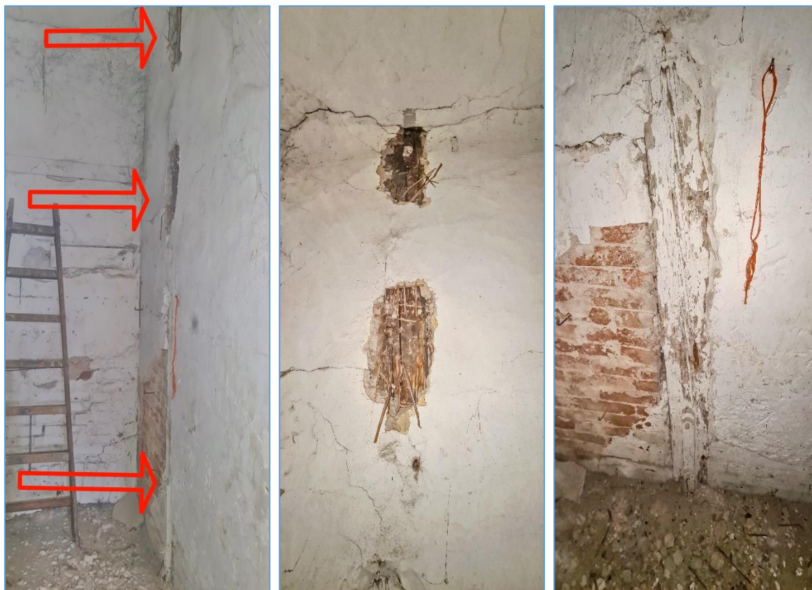
Obr.č. 7 – 8 – 9 – CELKOVÝ POHLED NA SVISLÝ ZAŽDĚNÝ TRÁM NA DRUHÉ STRANĚ PŘÍČKY – ODBĚR VZORKU VZ3 – INDEX B - C
