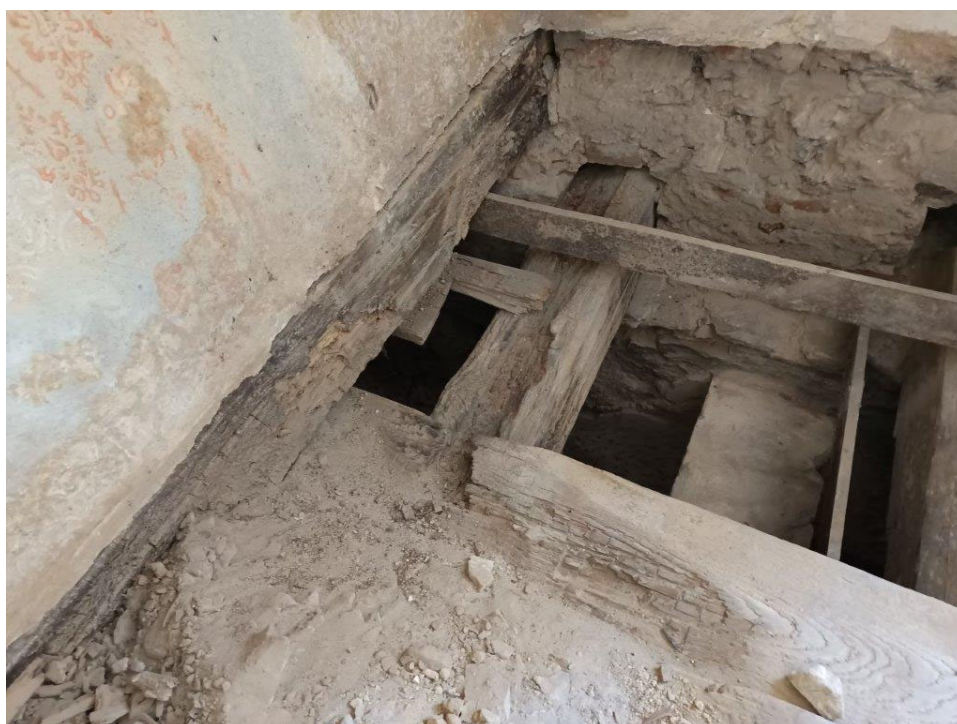
2. Dřevokaznou houbou napadená část stropní konstrukce 1.NP v místě cihelné příčky (severní větší místnost)
