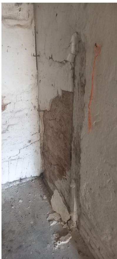
7. Pata vyvěšujícího dřevěného sloupku (2.NP - jižní užší místnost)
